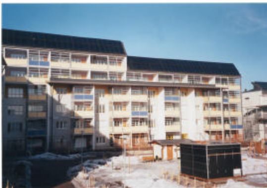
Kuva 11. Esimerkkejä kattointegroiduista aurinkokeräimistä Ekoviikissä, jossa on Suomen suurin aurinkolämpöhanke. Vasemmalla 250 m 2 kattointegroitu järjestelmä asuintaloon, oikealla keräimet muodostavat ulkorakennuksen katon (120 m 2 ) /Solpros/.
