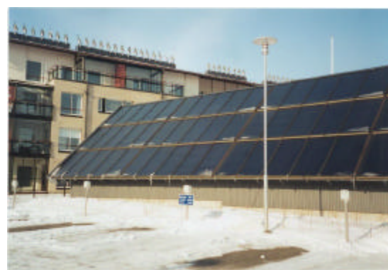
Kuva 11. Esimerkkejä kattointegroiduista aurinkokeräimistä Ekoviikissä, jossa on Suomen suurin aurinkolämpöhanke. Vasemmalla 250 m 2 kattointegroitu järjestelmä asuintaloon, oikealla keräimet muodostavat ulkorakennuksen katon (120 m 2 ) /Solpros/.
